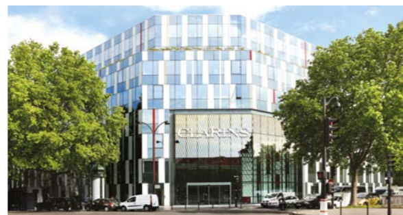
Siège Clarins Paris, immeuble haute qualité environnementale - © Clarins
